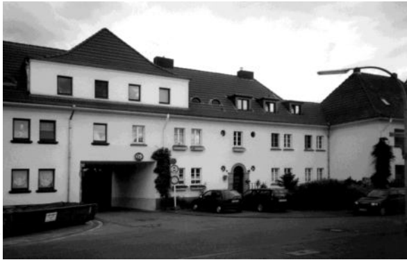
Torhaus zur Siedlung Brücker Heide am Klausenberg, 2004
