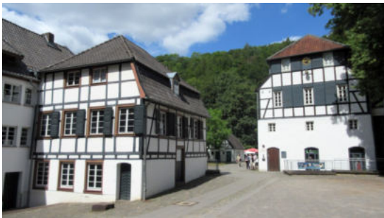
Sehenswerte Produktionsgebäude Alte Dombach
